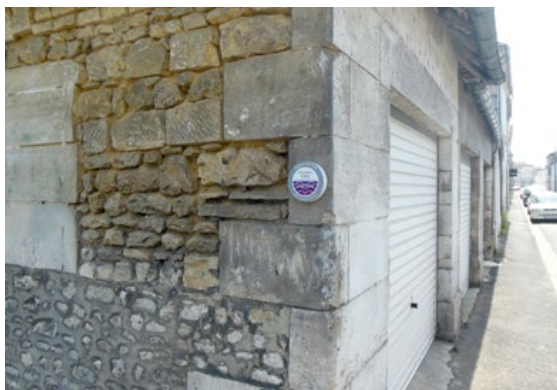
Repère de crue posé rue de Boutiers ©EPTB Charente
